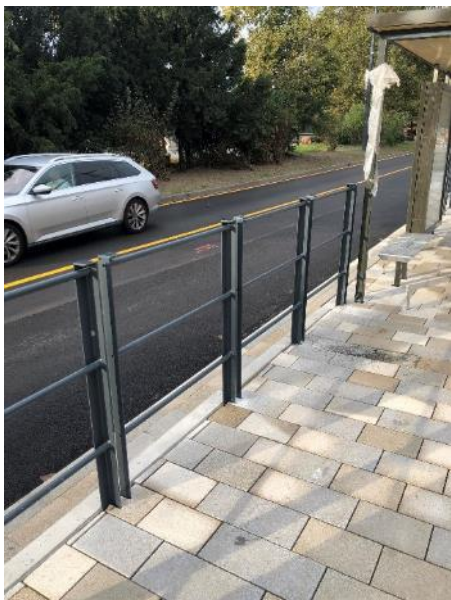
Obrázok 83_Příklad kotvení zábradlí pod povrchem dlažby
